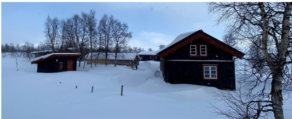
Bilde: Øyvollen mot sørøst med restaurert stall i midten, omsøkt utedo/uthus til venstre og gjeterbua til høyre.
