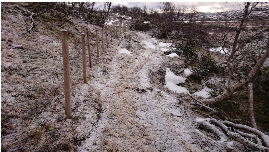
Slik ser situasjonen ut etter at gjerdet er flytta. Det ble 1 meter bedre klaring til selve fangstgropa
