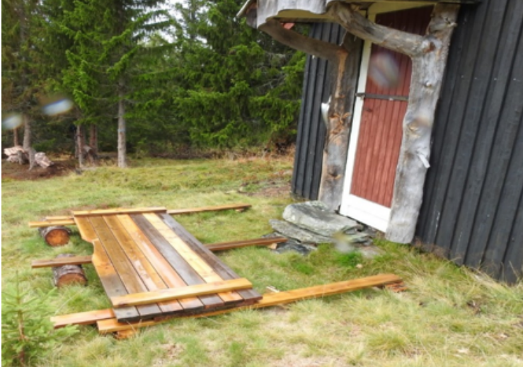
Det er laget en plankelem/platting foran inngangen til seterhuset.
