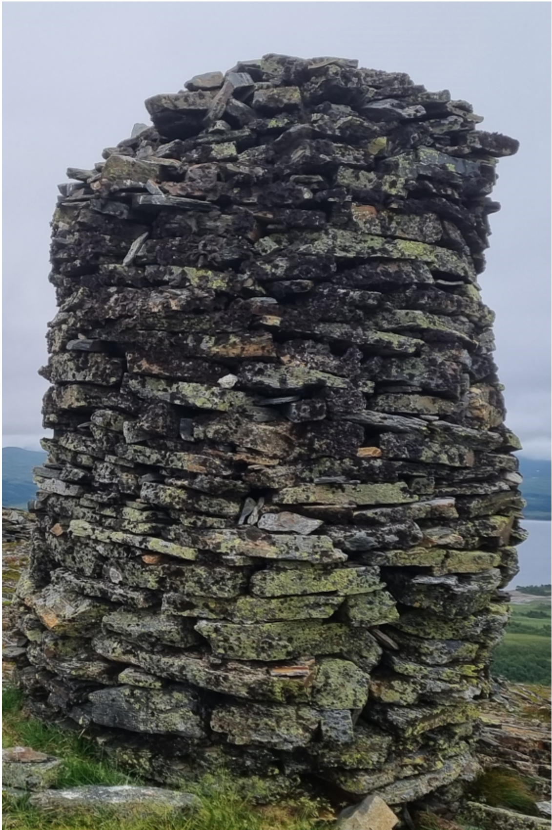
Varde/oppmålingspunkt på Blåkkåkleppen/ Blåahke bygd av stabsjunker Glad i 1875. Verneverdig kulturminne i Sylan landskapsvernområde. Opprinnelig var varden 6 fot høy, 5 fot bred og flat på toppen, men fra midten av 1970-tallet kom nye varder opp, og folk la stein på toppen av varden slik at den fikk ny form.
