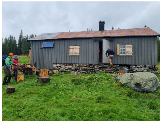
Bilde av framsiden til seterhuset fra befaring 05.09.2023.
