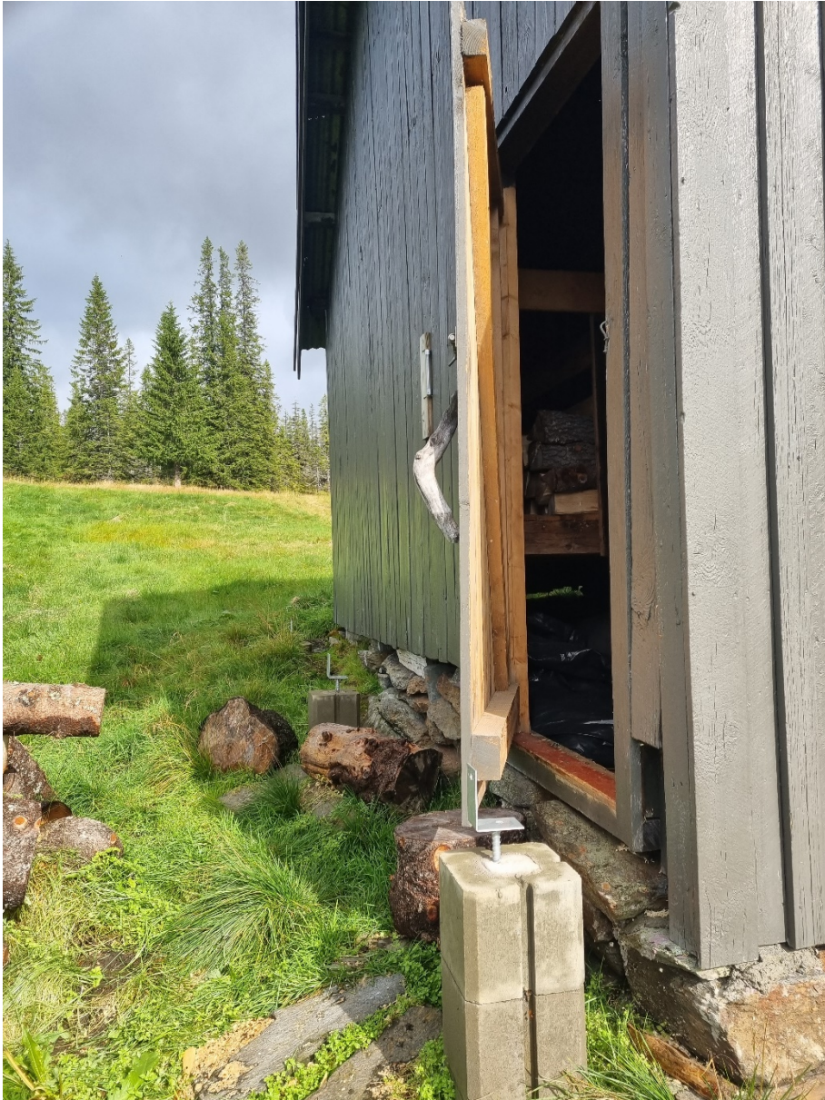
Erstatte kortvegg mot vest med laftet vegg. Fundament klargjort.
