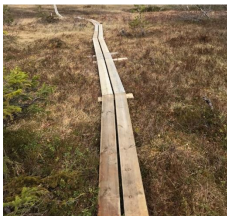
Eksempel på klopplagt strekning på turstien til Storskarven.
