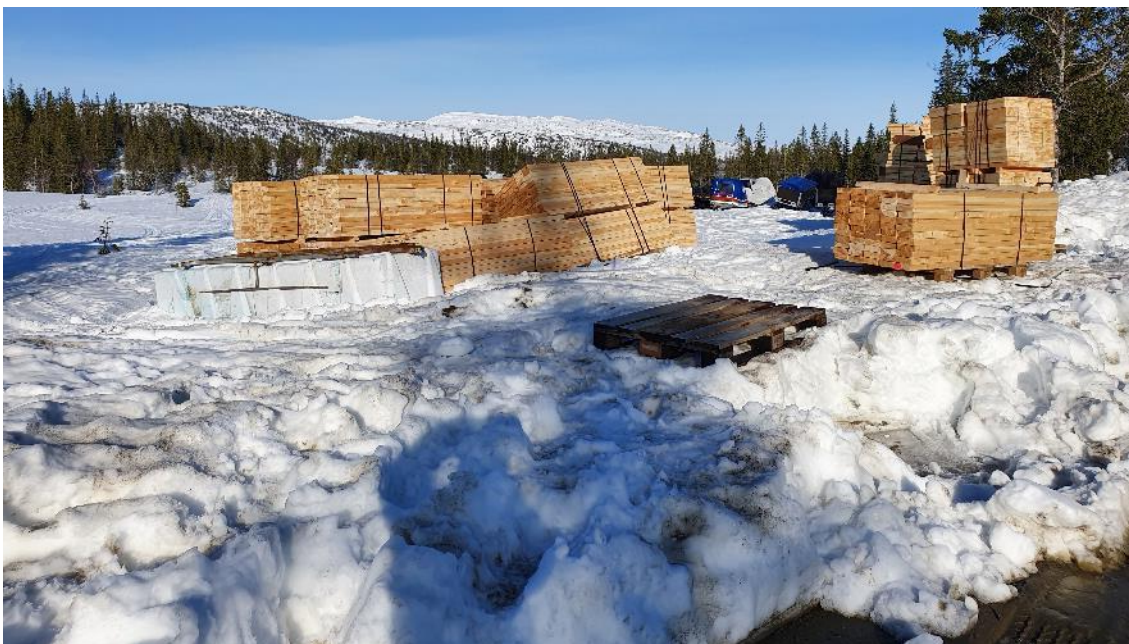
Store mengder klopp som skal fraktes inn. Dette er nok til 1 km ferdig lagt klopp
