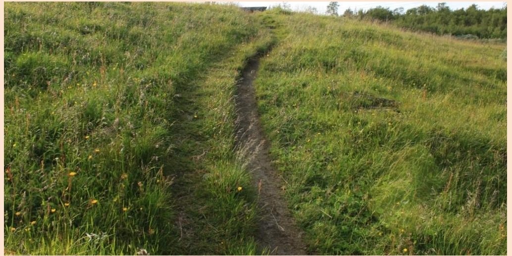
Figur 46. Fra stien på Sankåvollen. Stien slites noe ned i underlaget, og antydninger til dobbeltspor oppstår. Foto: Jon Opheim 23.08.2017.
