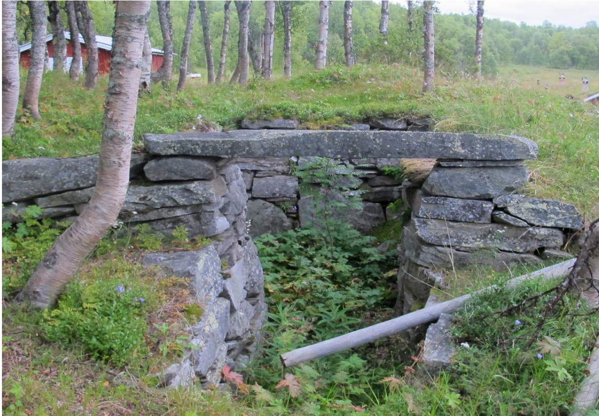
GRUNNMUR ETTER ELDRE FJØSBYGNING PÅ RIHÅVOLLEN. FOTO: KNUK SIMENSEN, 2015
