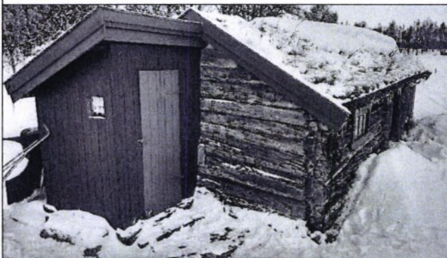
Tverrvegg mot sørvest der utedoen var plassert.
