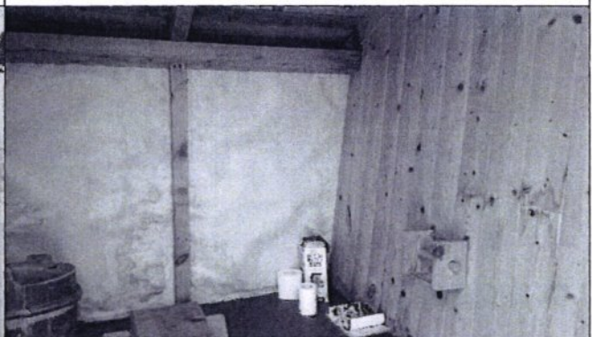
Innvendig i utedoen. Pappsjikt som vindtetting og låvepanel utvendig. Faspanel på vegg mot tømmeret.
