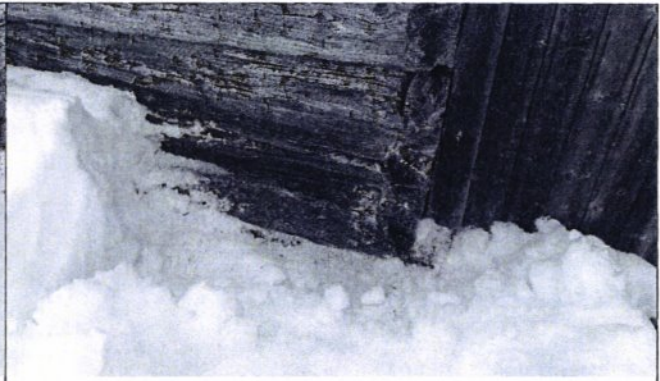
På denne langveggen er det også lagt inn utskifting av 2. omfaret.
