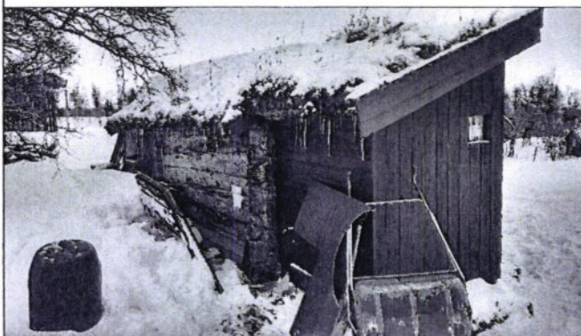
Tverrvegg og bakvegg mot nordvest.
