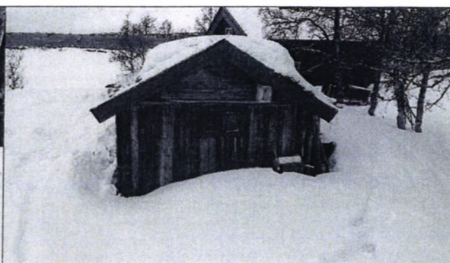
Tverrvegg mot nordøst. Her er det kun lagt inn utskifting av svill. Her ser vi for oss at utedoen plasseres.
