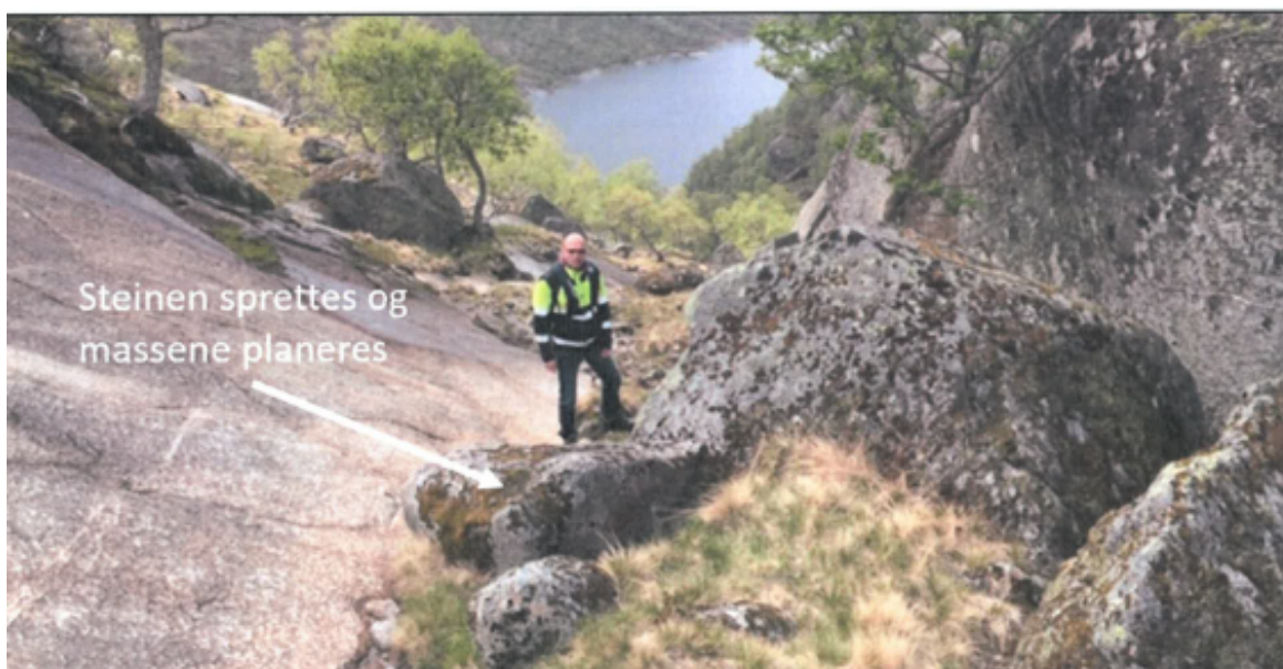
Den store steinen i midten sprettes og massene planeres ut.
