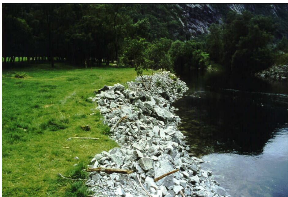
Figur 15 Utfylling/elveforsterkning i Fraffjordelva
