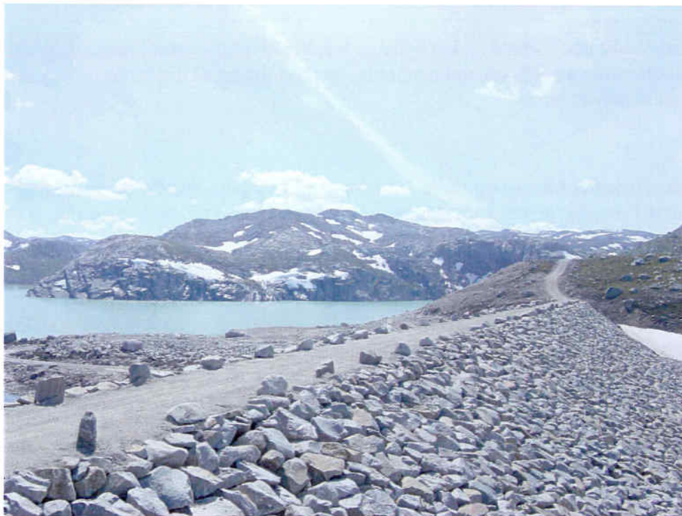
Figur 2.12 Den nye steinfyllingsdammen ved Stora Flørvatn. Foto Svein Dam Elnan
