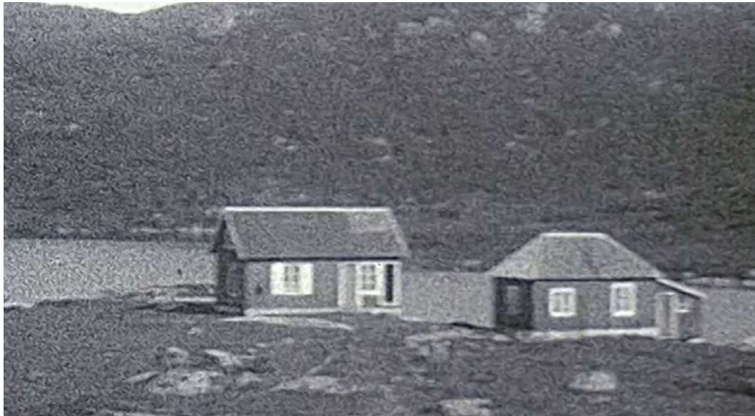
Gammelt bilde av stallen og forpakterbolig som viser tilbygget mot øst.
