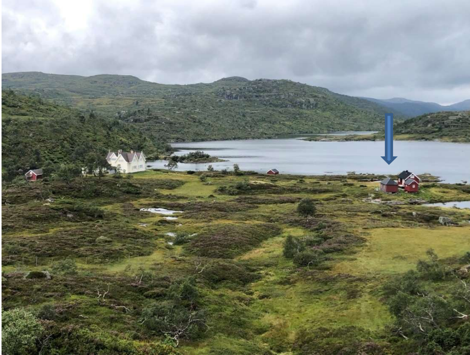
Oversiktsbilde: til venstre i bilde vises Lordehytta- søknaden omhandler rivning og bygging av forpakterbolig som ligger lengst til venstre av de tre røde bygningene til høyre i bilde (se blå pil). Foto: Åseral kommune
