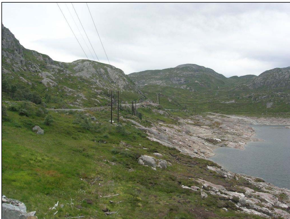
Bilde 8. Eksisterende 22 kV-linje ved Breidava. For prosjektet i Gråfollåna er det ønske om å utvide linjekapasiteten på eksisterende master, eventuelt føre opp et parallelt løp langs denne linja.
