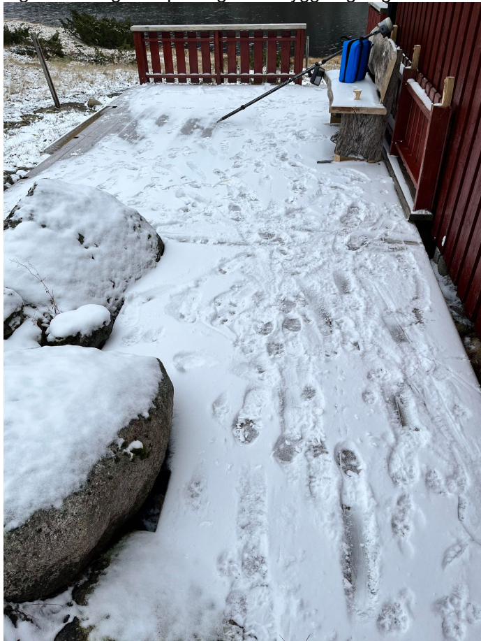
Figur 4: Påbygd plattform i front, retning sør-øst. Areal målt til 15,7 m 2 . Denne delen kreves fjernet.
