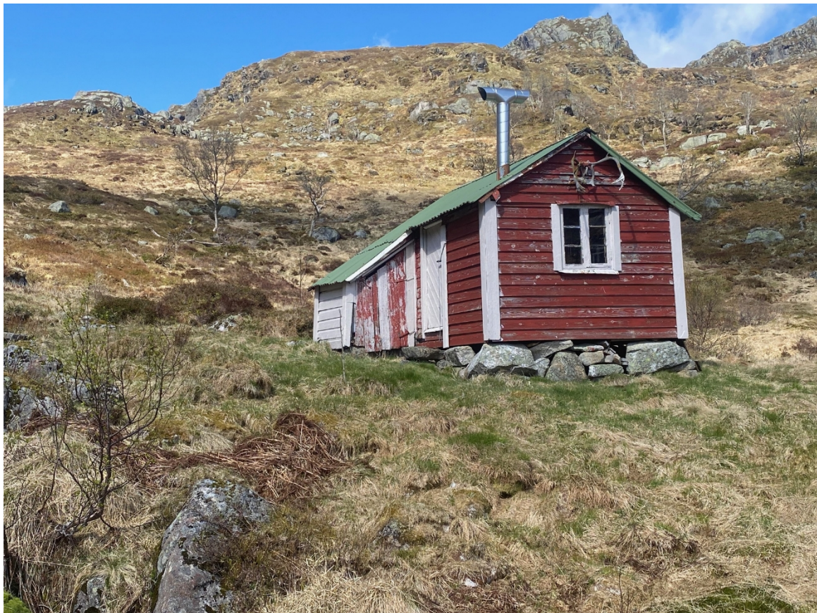
Foto av eksisterande bygning på Rettlandshommå. Foto: SVR.
