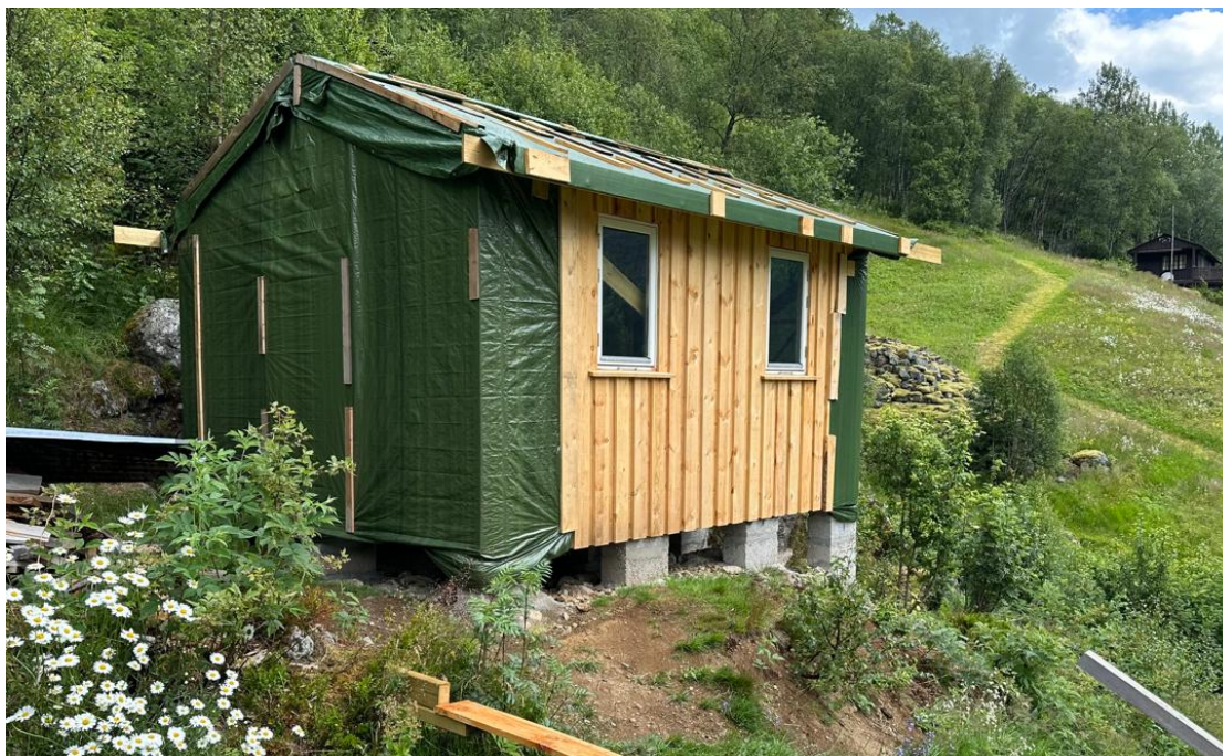
Nytt påbegynt uthus sett fra stuevindu i hytta. Kledning er satt opp på begge langsider, presenning er lagt på kortsidene og tak.
