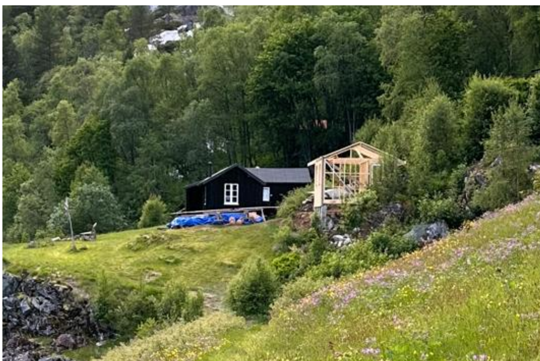
Reisverk nytt uthus sett fra øst, delvis skjult bak busker og trær i terrenget.
