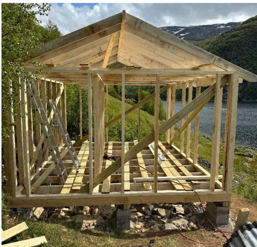
Reisverk på nytt uthus, sett fra vest, med åpning til to nye dører, helt opptil toppsvill, der sperrene starter. Dette er bygd så lavt som mulig, brukt tilsvarende takvinkel som hytta, 22,5 grader.
