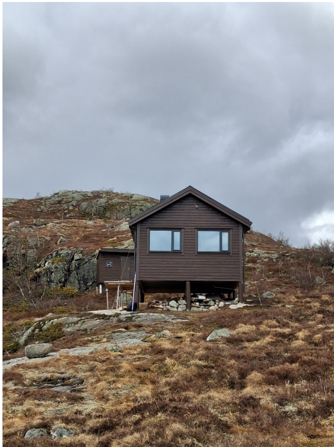
Foto av sankehytta. Fotoretning mot nord.
