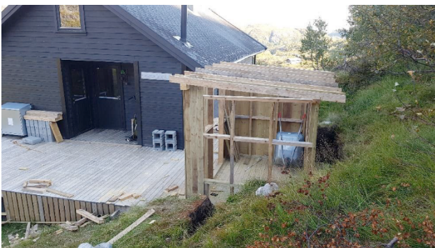
Bildene viser vedbod under oppbygging.
