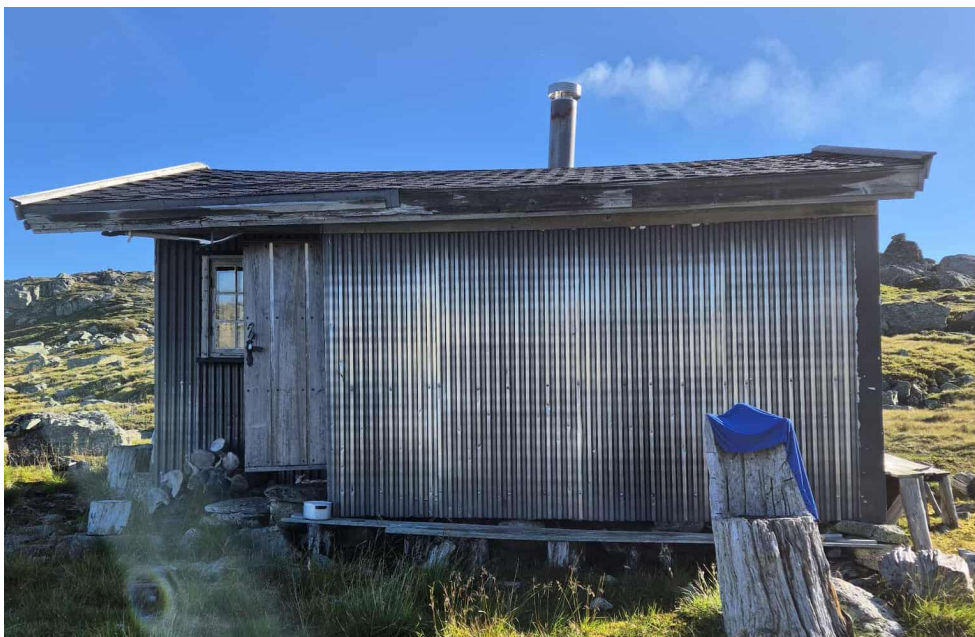
Dagens fasade sør. Tilbygg er tenkt langs vegg nærast, i heile lengda, og inntil 2 meter ut frå dagens vegg.
