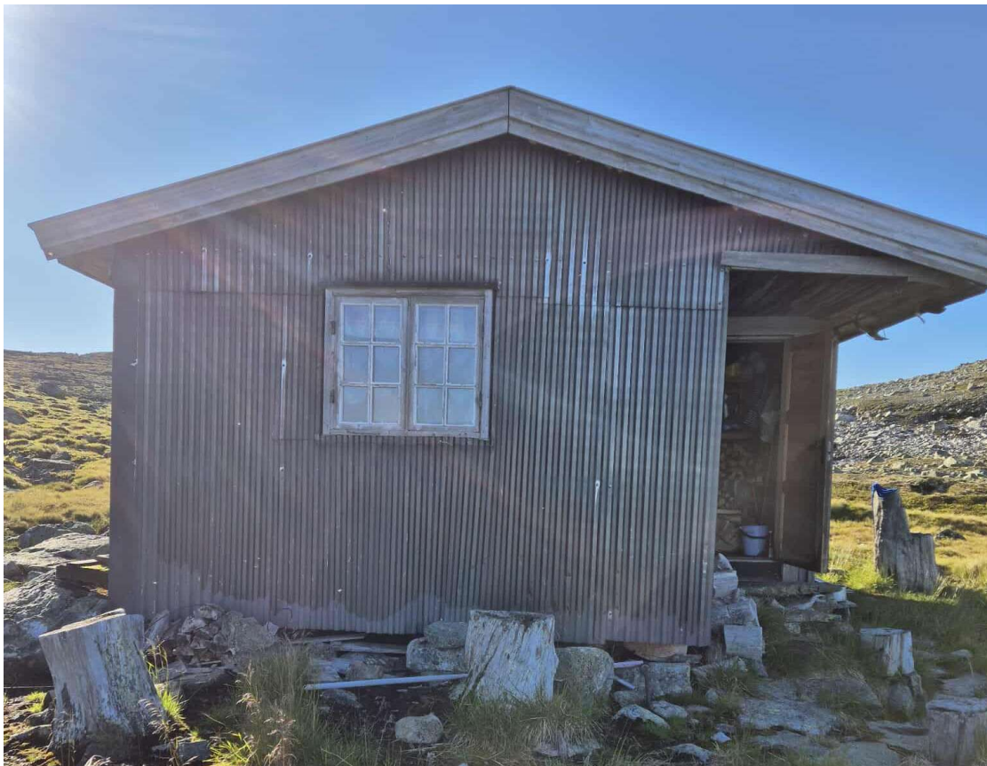
Dagens fasade vest. Tilbygg er tenkt langs vegg til høgre for inngangsdør.
