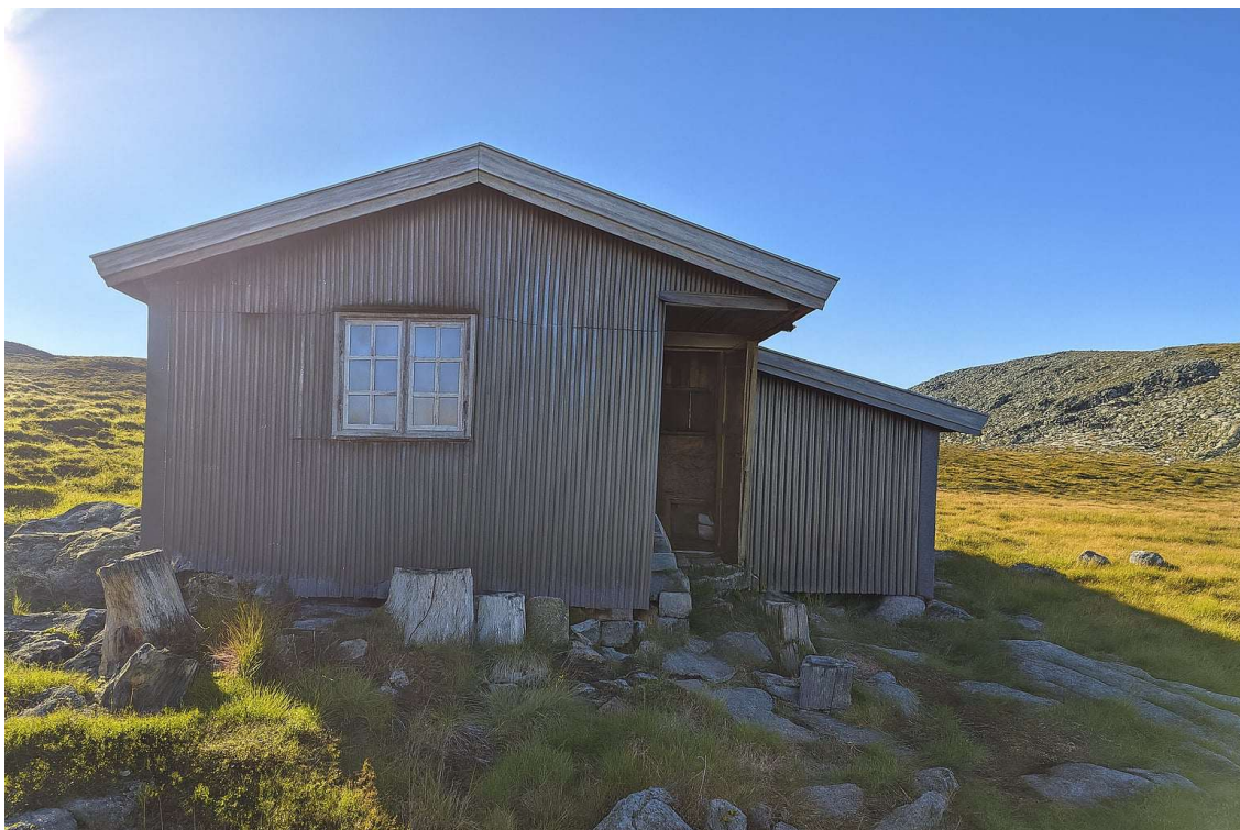
Fasade vest med planlagt tilbygg inntegna til høyre.
