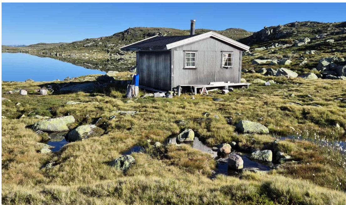
Dagens bu sett fra aust (Fasade aust (gavlvegg) og sør). Planlagt tilbygg er tenkt langs veggen mot sør.
