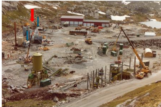
Foto 1: ukjent år, muligens 1981, før foto 2: synlige flere tanker (blå pil). Asfaltverk vises med rød pil
