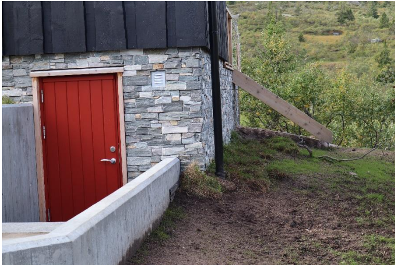
Figur 4 lagt til utfylling langs grunnmur
