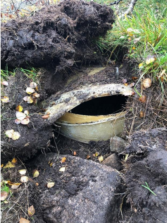
Figur 2: kum er gravd ned på nordsiden av hytta
