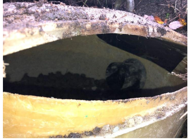
Figur 1: et rør kommer ut i kummen som er gravd ned fra hytta til kum
