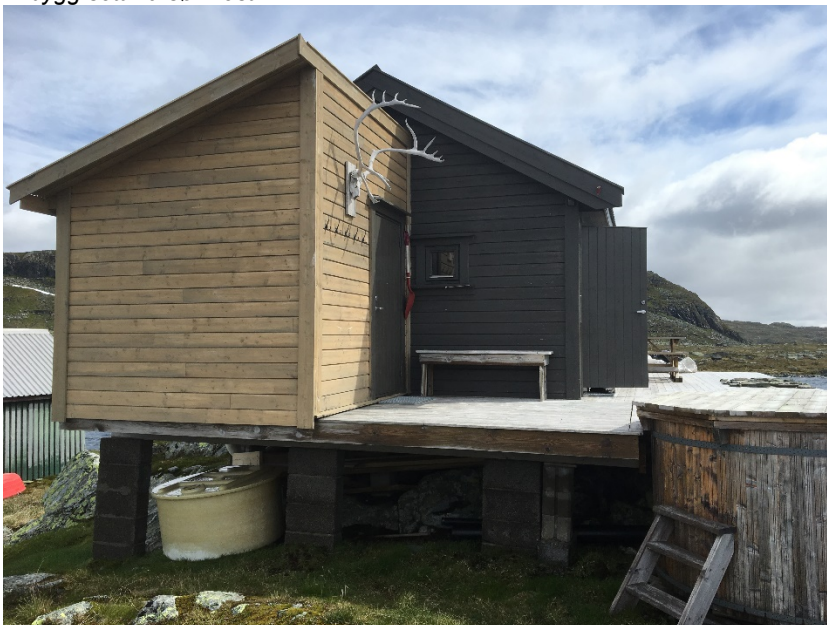
Tilbygg sett frå sør-vest
