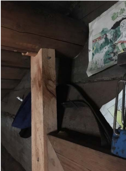
Døme på mellombels understøtting/avstiving inne i bui.
