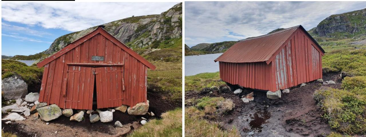
I tillegg til at dette naustet er preget av mye råte i reisverk og kledning, så har her også fundamentene rast sammen. Antakelig skyldes dette at en bekk har funnet et nytt løp, og nå passerer like inntil den østre fasaden av bygget. Fundamentene her har vært stein som er stablet på løsmasser. Når løsmassene dreneres bort så ødelegges også fundamentene. I tillegg er 1-2 av takplatene ødelagt.
