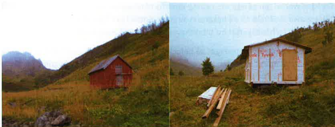
Gammel og ny bygning på Straumnes. Se rapport fra SNO for flere bilder og teknisk beskrivelse av nytt bygg.
