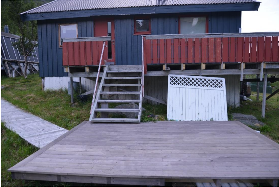
Sørveggen, bilde fra 2020.
