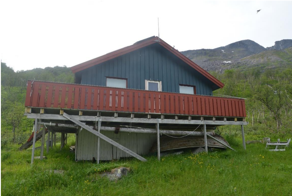
Østveggen, hvor det søkes om å bytte ut altandøra med en skyvedør. Bilde fra 2016.
