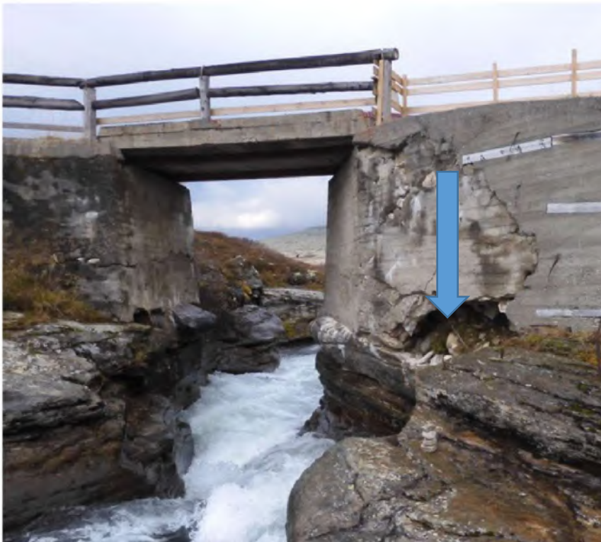
Bilde hentet fra Akontroll AS sin rapport levert til Statskog SF som viser brukar og delvis fyllmasser i brukaret (blå pil)
