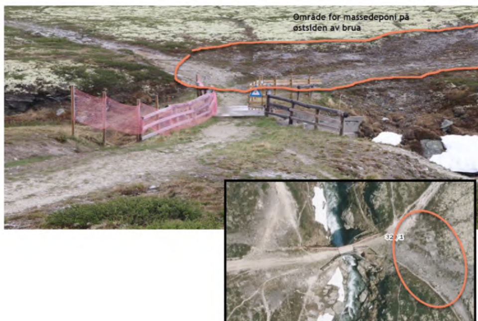
Figur 3.: Bilde viser område for massedeponi på østsiden av brua. Topplaget/torv vil bli skrelt av, tatt vare på og lagt på toppen av massedeponiet for raskere revegetering.
