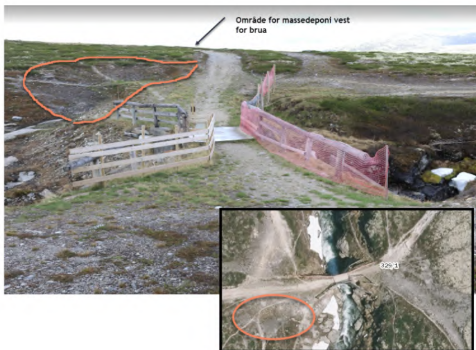
Figur 2.: Bilde viser område for massedeponi på vestsiden av brua. Topplaget/torv vil bli skrelt av, tatt vare på og lagt på toppen av massedeponiet for raskere revegetering
