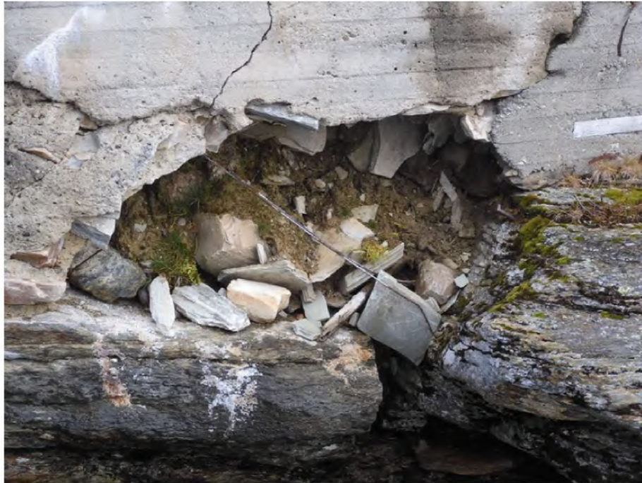
Figur 4 Avskalling og erosjon oppstrøms
