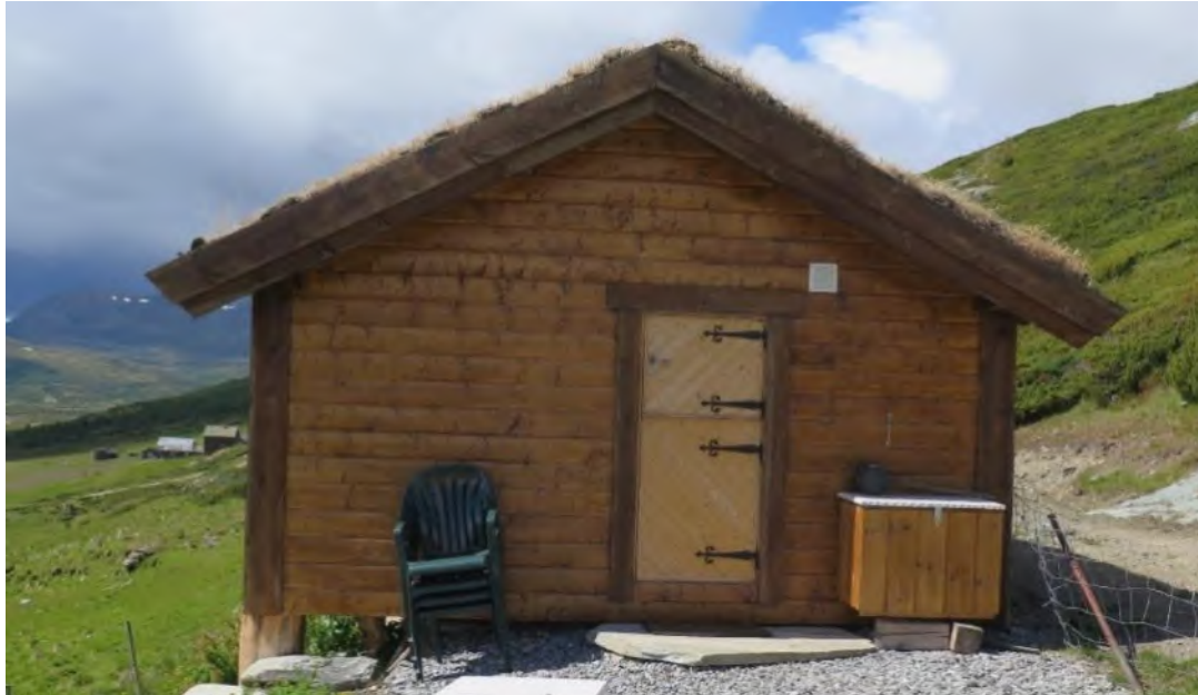
Bilde av gjennomført byggetiltak på Tverrlisetre gbnr 86/1 fnr 45 fra SNO sin rapport.
