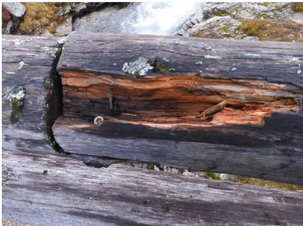
Figur 5 Råte i rekkverk
