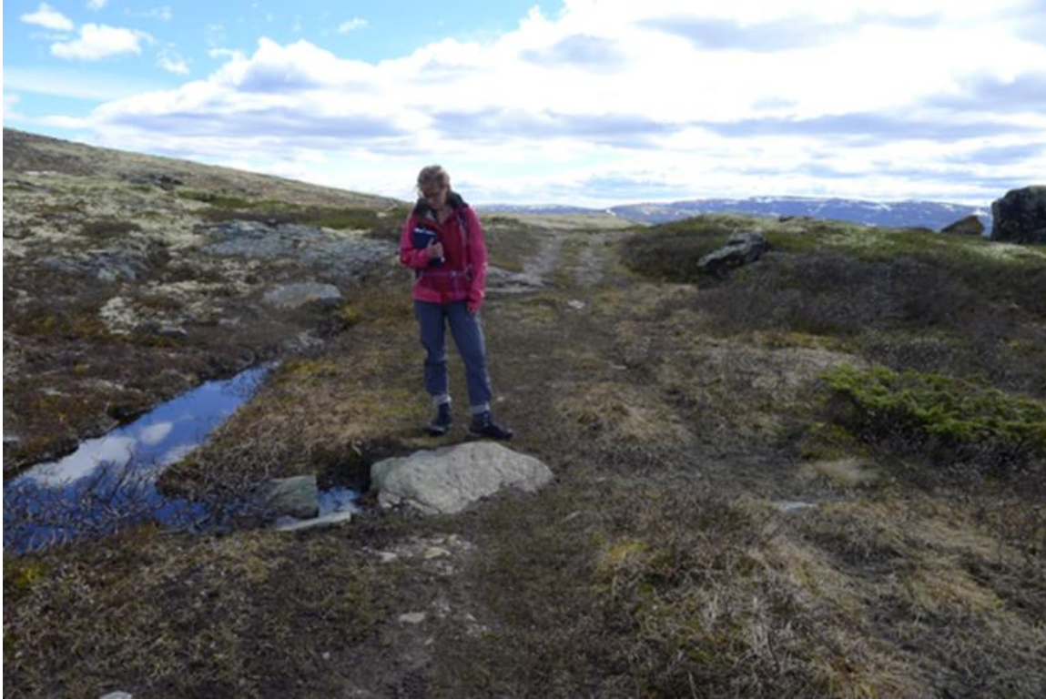
Kollapset stikkrenne sør for Hardbakken. Foto: Ann Kristin Engh
