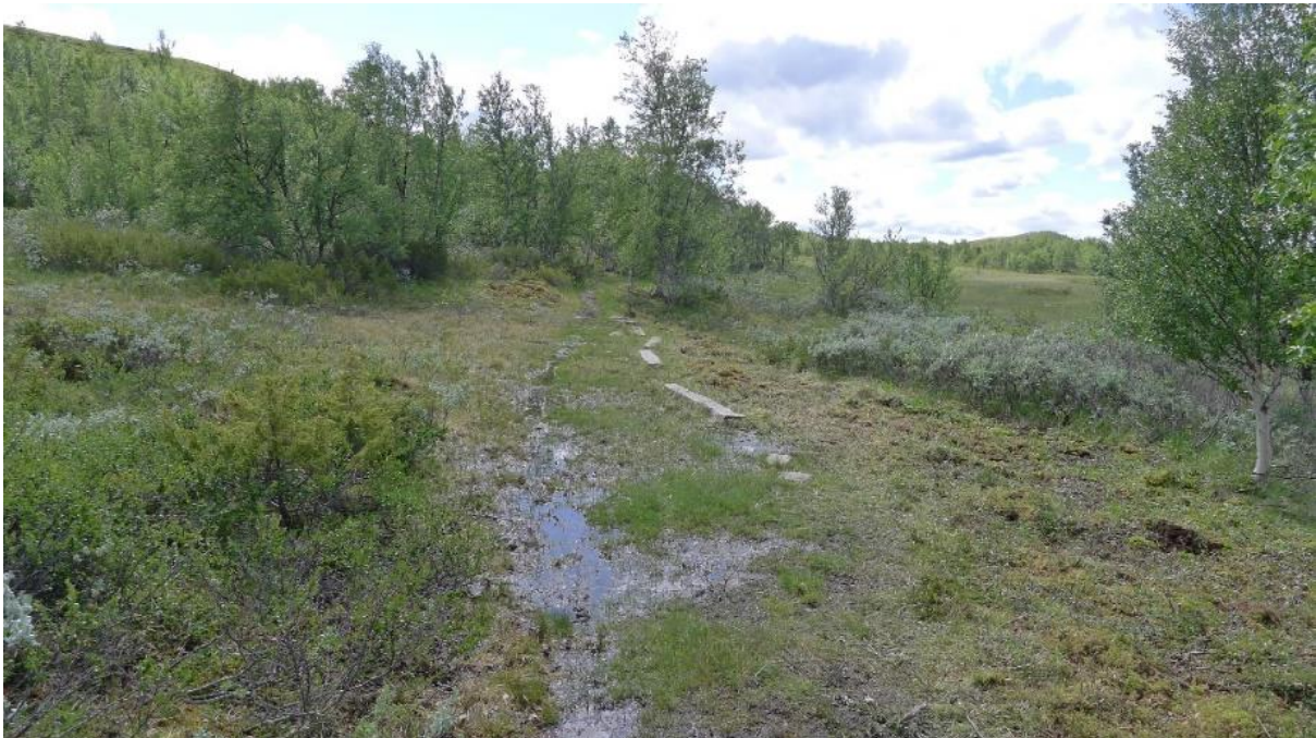
I dette området møtes den yngre og den eldre Kongevegen. Området er vått og det er eldre kreosotimpregnerte stokker som bør erstattes med en mer varig løsning. Foto: Marit Johansson
