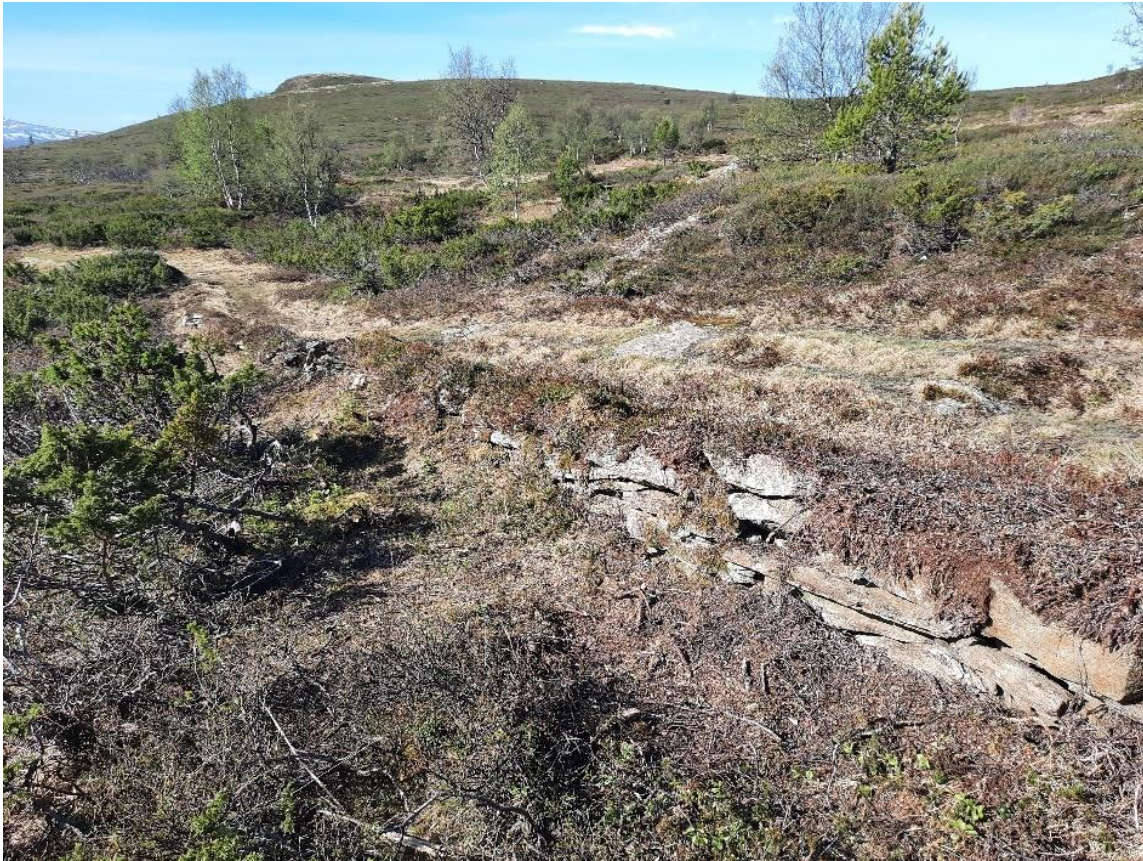
Tørrmuring på strekningen mellom Ståkån og Bønnealteret, ryddet fram i 2020. Foto: Marit Johansson
