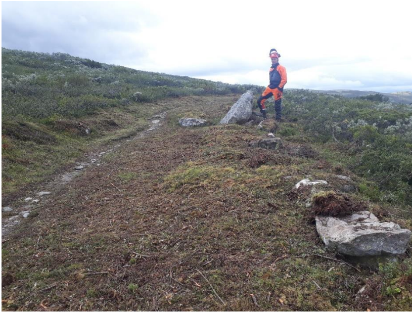
Stabbestein og deler av vegoppbygging ryddet fram i 2019. Foto: Marit Johansson
