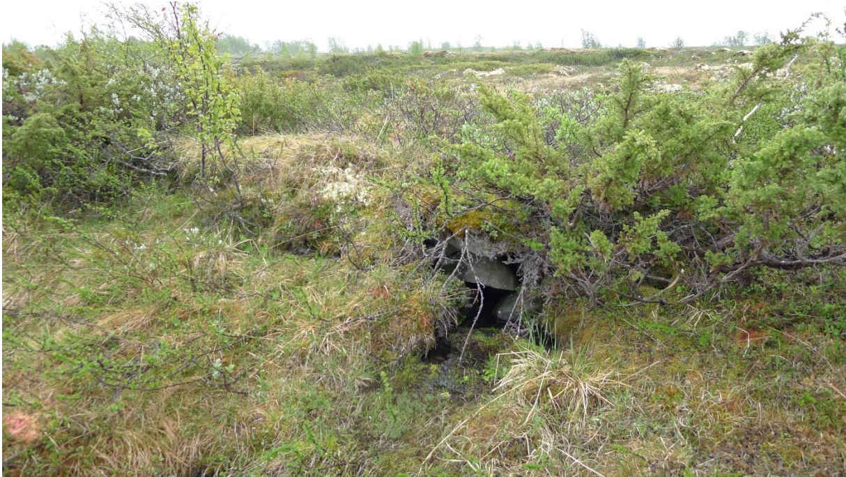
Stikkrenne som er synlig i vestre oppbygning på Kongevegen som går gjennom myra sør for Fokstugu. Foto: Marit Johansson
