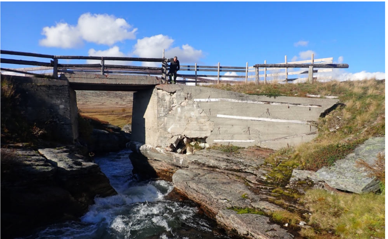
A1 – Oversikt fra oppstrøms side
