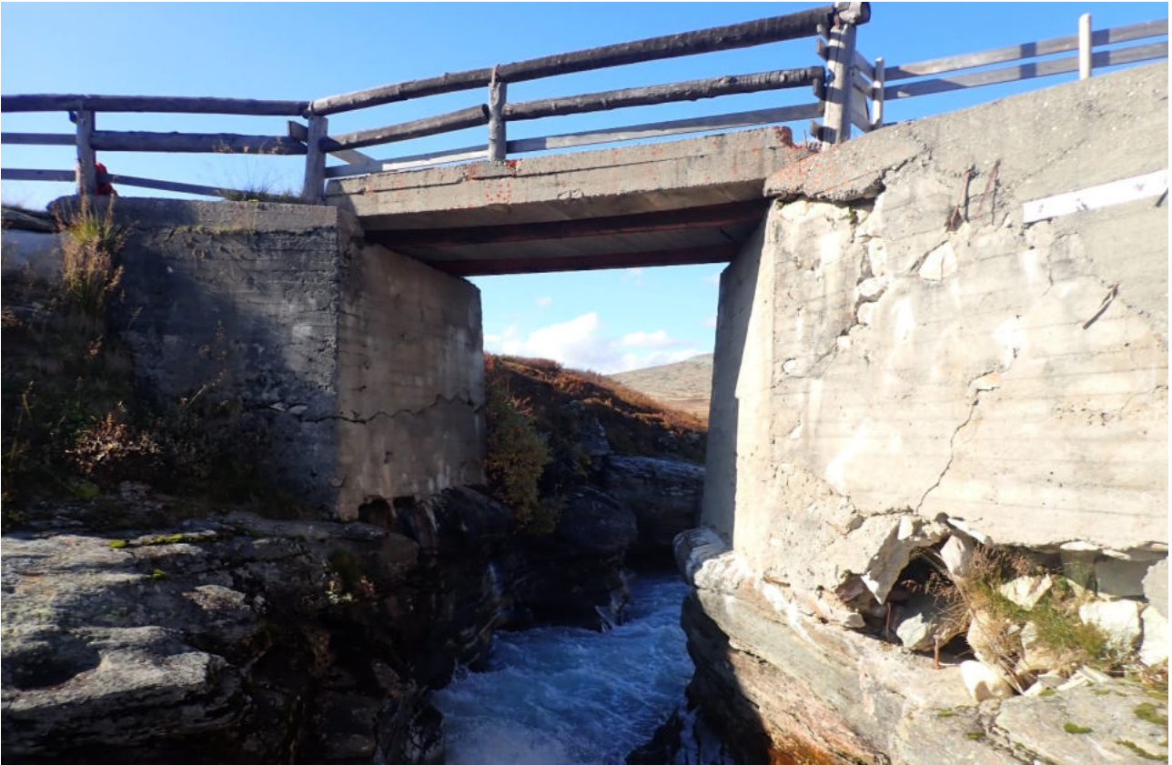
A2 – Oversikt fra oppstrøms side
