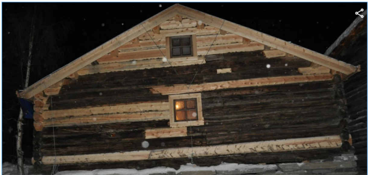
Figur 2. Eksempel på innfelling av tømmerdeler i gammel bygning.
