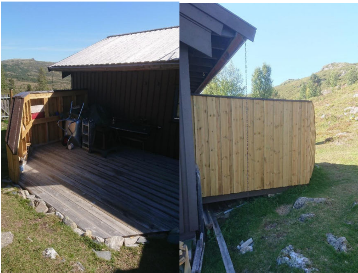
På hovedbygningen er det bygd en plattform med levegg. Plattformen er 5,50 m lang og 4 m brei, totalt 22 m 2 . Leveggen er 5 meter lang og 1,65 meter høg.
