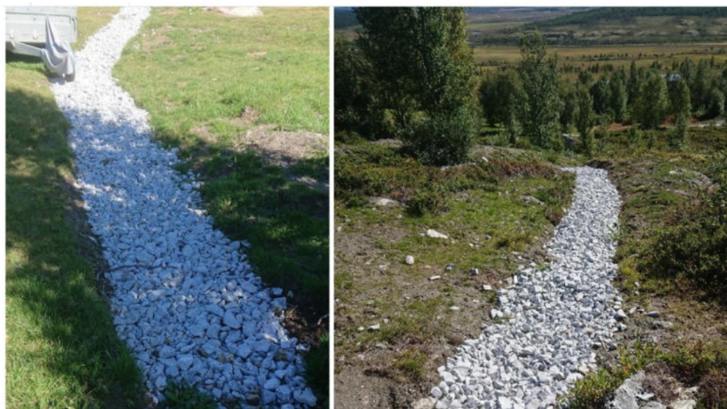
Figur 4: Bildet til venstre viser omsøkt ny grøft på 45 meter. Bildet til høyre viser eksisterende grøft, omsøkt utbedret og påført pukk (bilder fra oppsynsrapport)
