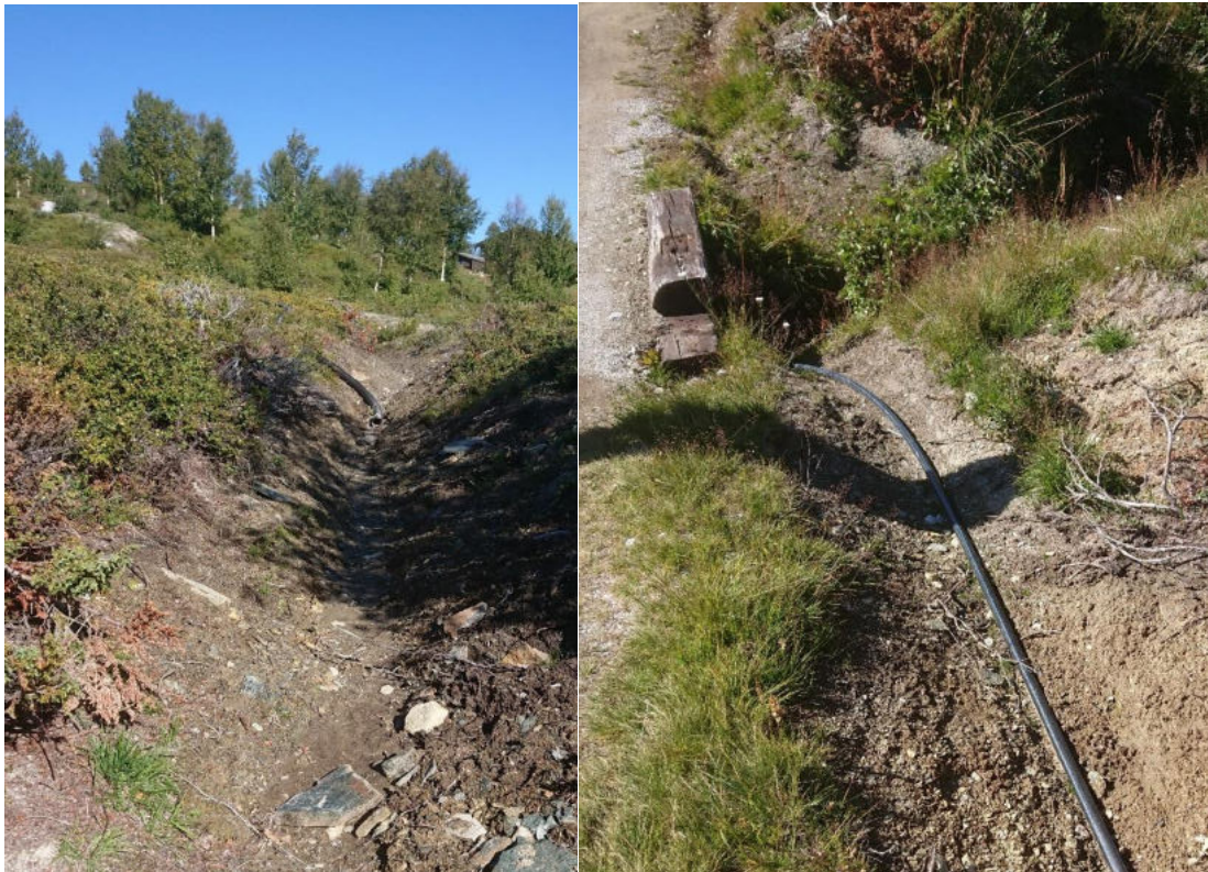
Det er gravd 60 til 100 meter åpen grøfter, med bredde ca 1,5 meter og ca 40 cm dype.
