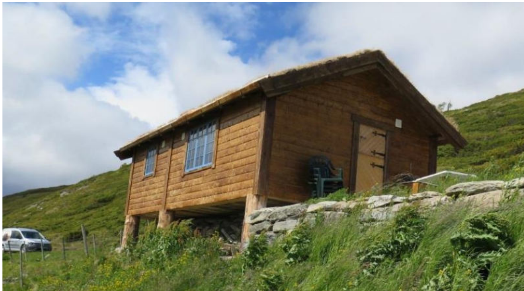
Bilde av gjennomført byggetiltak på Tverrlisetre gbnr 86/1 fnr 45 fra SNO sin rapport.
