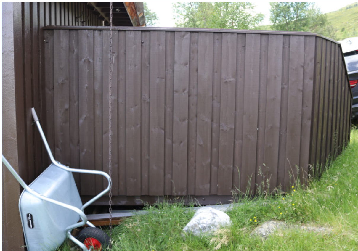
Figur 14. Levegg, utvendig, mot øst.
