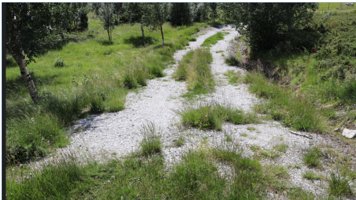
Figur 12. Oppfylt kjørespor, øvre del.
