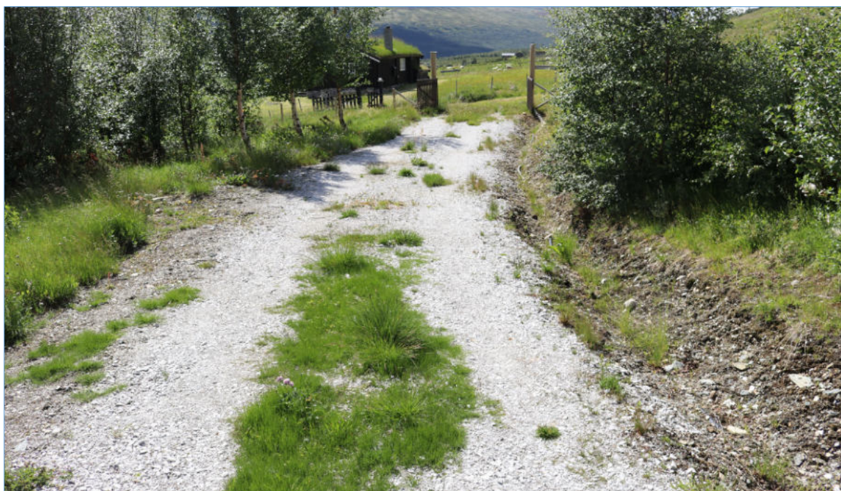
Figur 13. Oppfylt kjørespor, nedre del.
