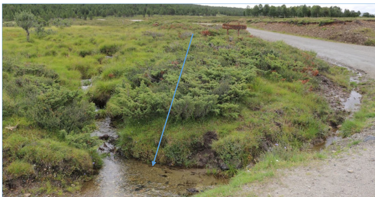
Figur 4. Foto med planlagt plassering av avskjæringsgrøft.
