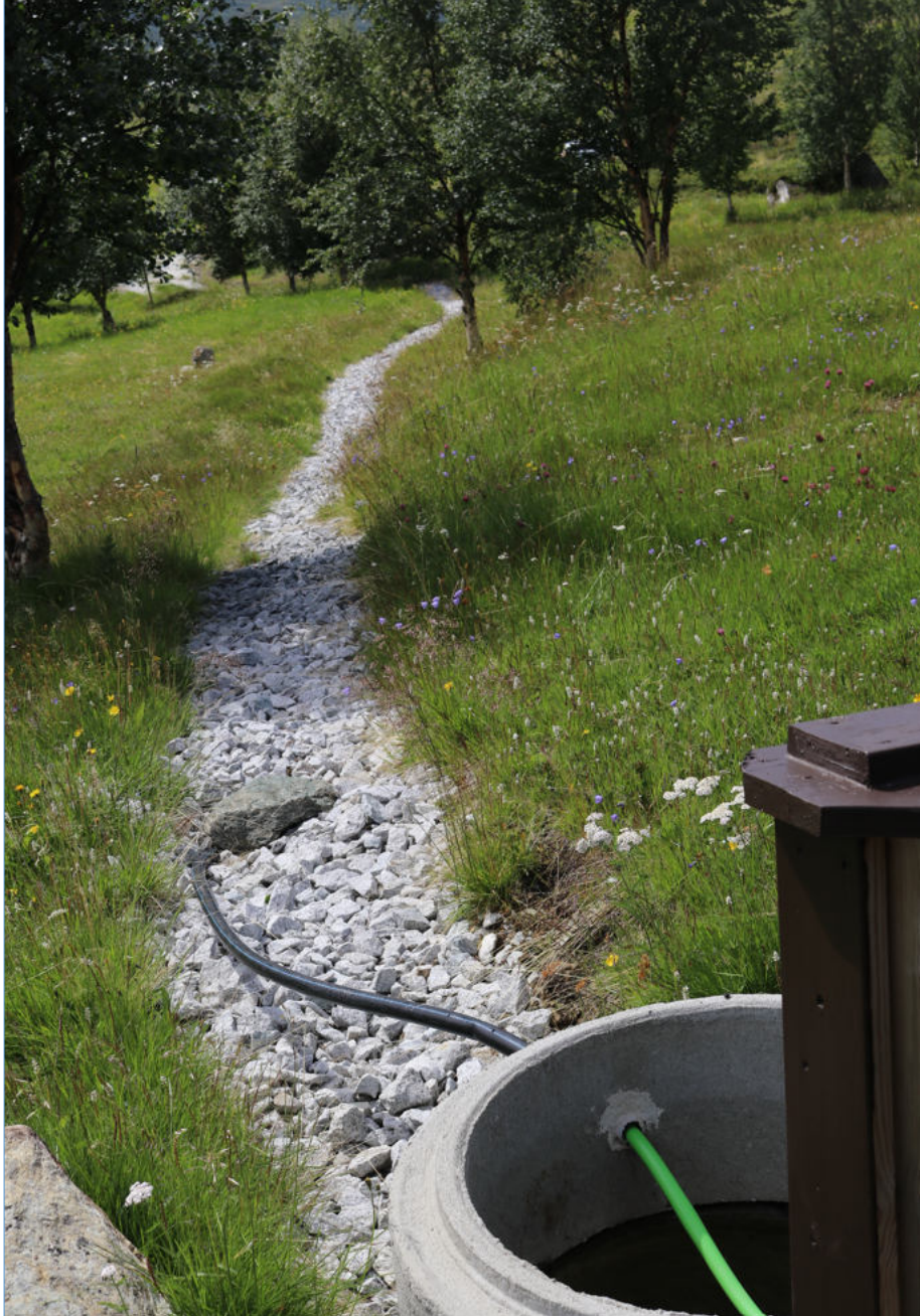
Figur 8. Grøft 3, fra vannkum og nedover.
