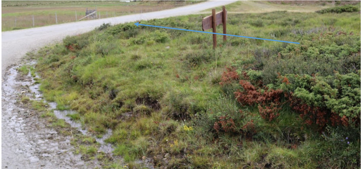
Figur 5. Foto med planlagt plassering av avskjæringsgrøft.
