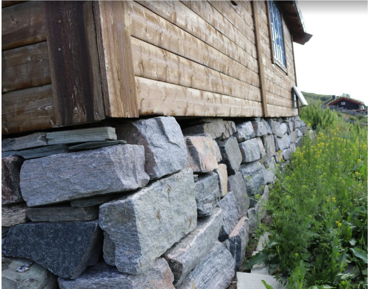
Foto 5. Forblendingsmur under langveggen.
