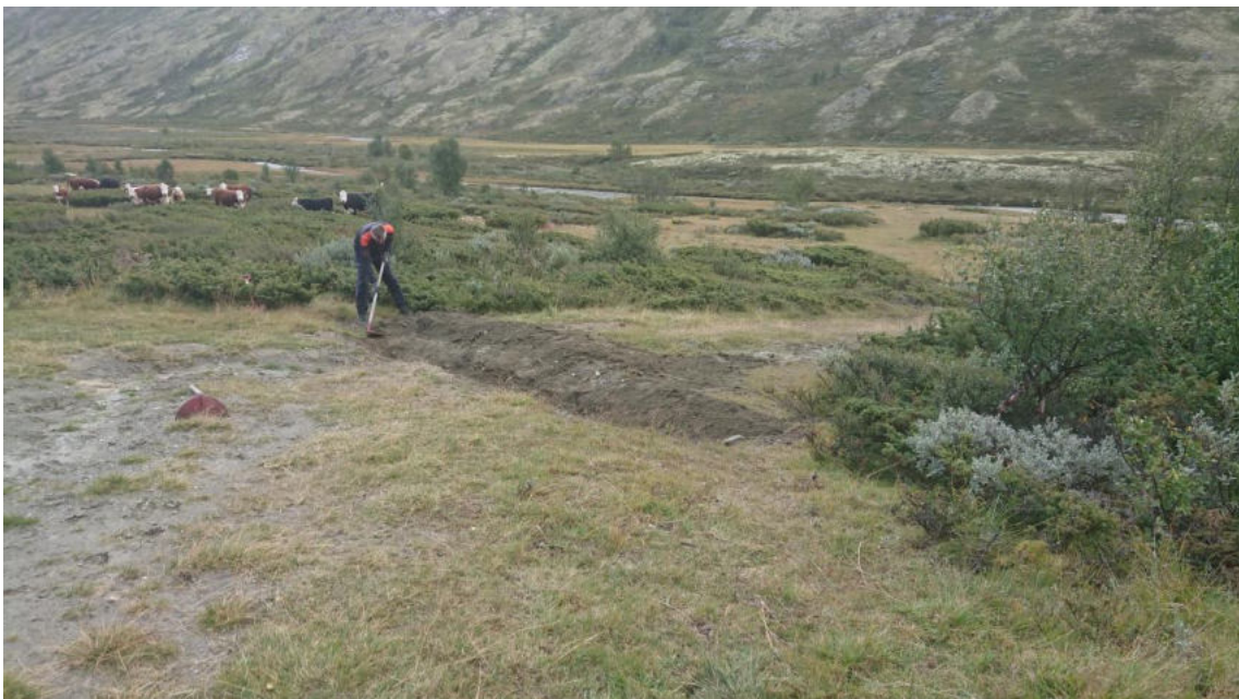
Avskjæring av vei ned til Grimsa.
