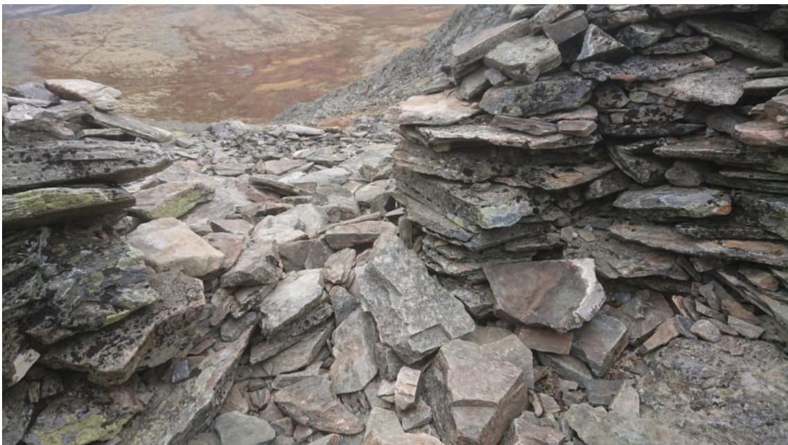
Skader på fangstrusa på Formokampen.
