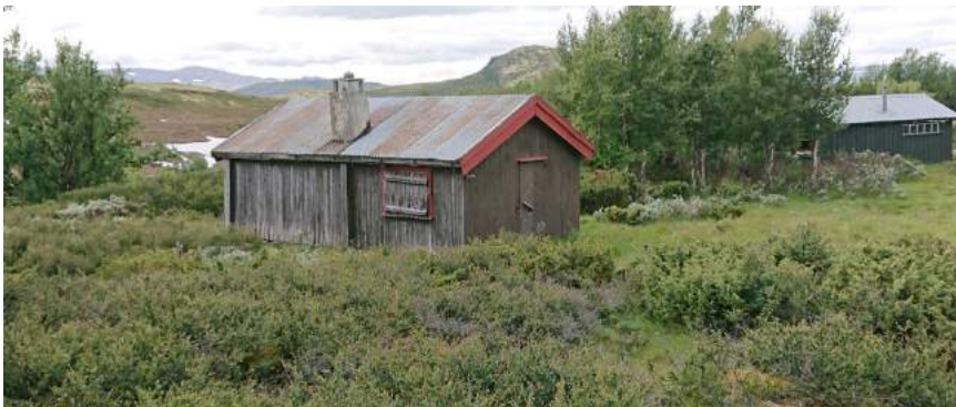
Figur 4: Bilde av eksisterende måsåbu fasade mot øst
