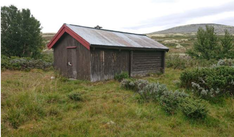
Figur 3. Bilde av eksisterende måsåbu fasade mot vest
