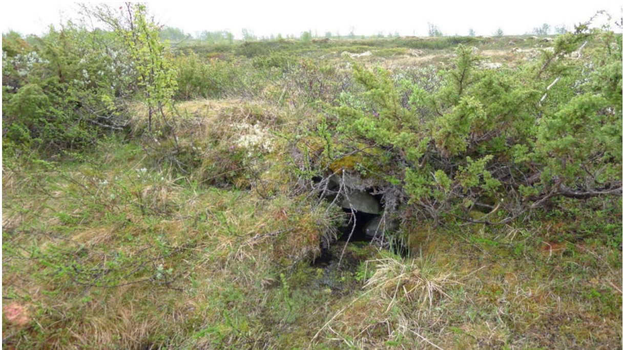
Stikkrenne som er synlig i vestre oppbygning på Kongevegen som går gjennom myra sør for Fokstugu. Foto: Marit Johansson
