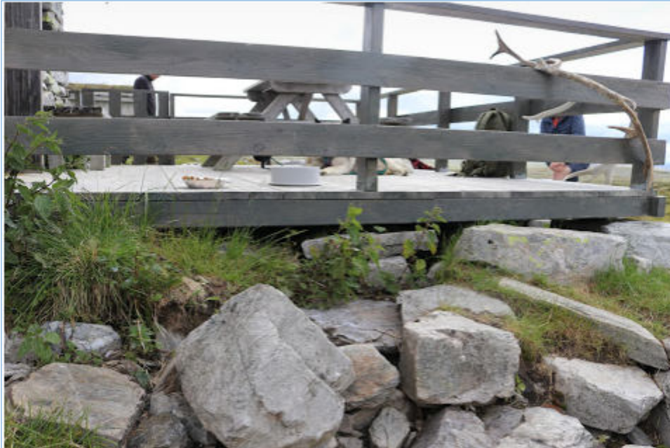
Figur 10. Fra Rundhøbua – befaring 2020.
