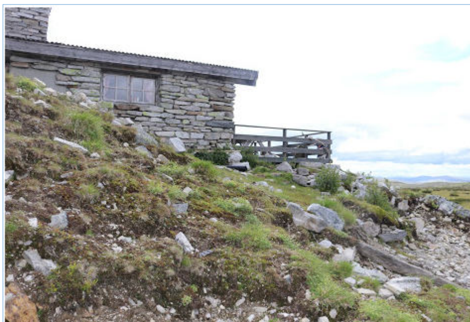
Figur 9. Fra Rundhøbua – befaring 2020.
