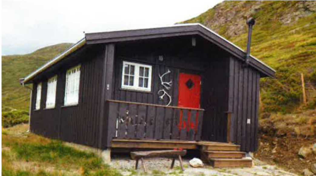
Bilde fra SNO sin rapport som viser gjennomført tiltak i strid med vedtak fra 2013.
