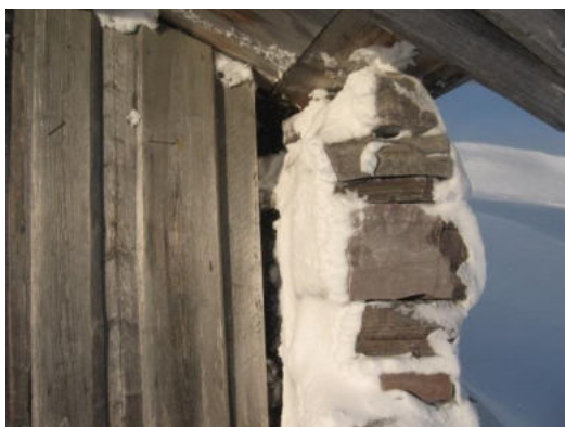
Bildene viser utglidning mellom steinmur og vegg med kledning av tre.
