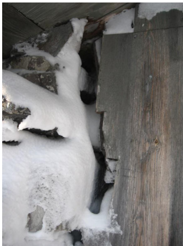
Bildene viser utglidning mellom steinmur og vegg med kledning av tre.
