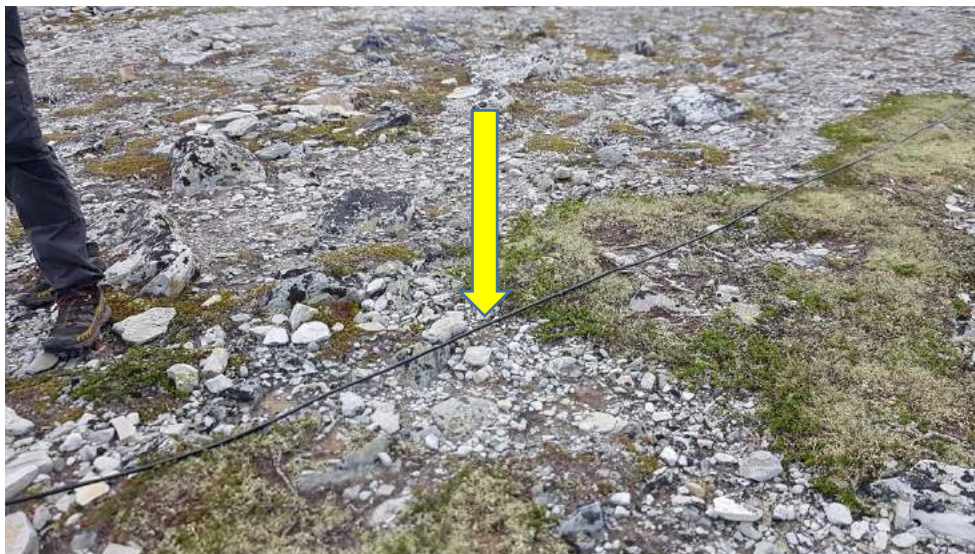
Bilde viser antennekabel før den er skjult i terrenget
