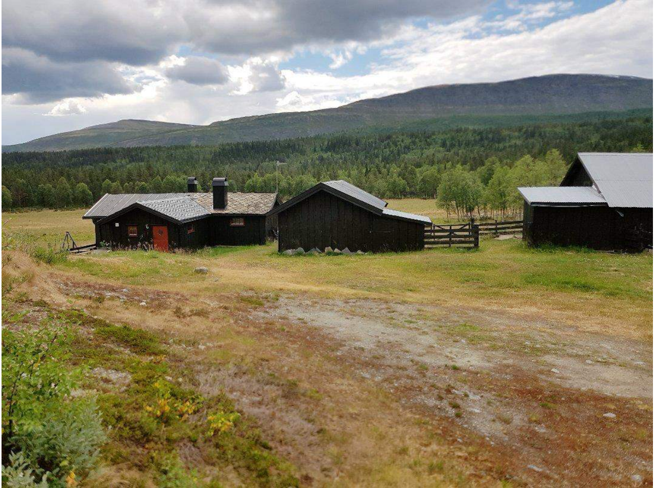
Bilde 2: Bilde tatt av nasjonalparkforvalter sommeren 2018, etter oppføring av nytt tilbygg.
