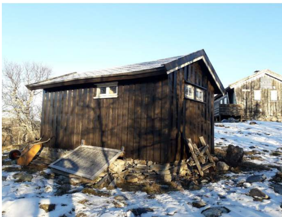
Eksisterende uthus. Hovedhytta ses i bakgrunnen.
