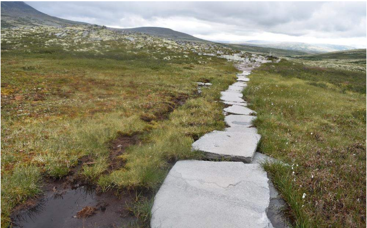
Figur 24. Steinheller lagt ut over sammenhengende større myrområde for et par sesonger siden. Det ser ut som all ferdsel nå kanaliseres over hellene og gjenveksten i de parallelle stiene i myra er godt i gang. Foto: Dagmar Hagen.
