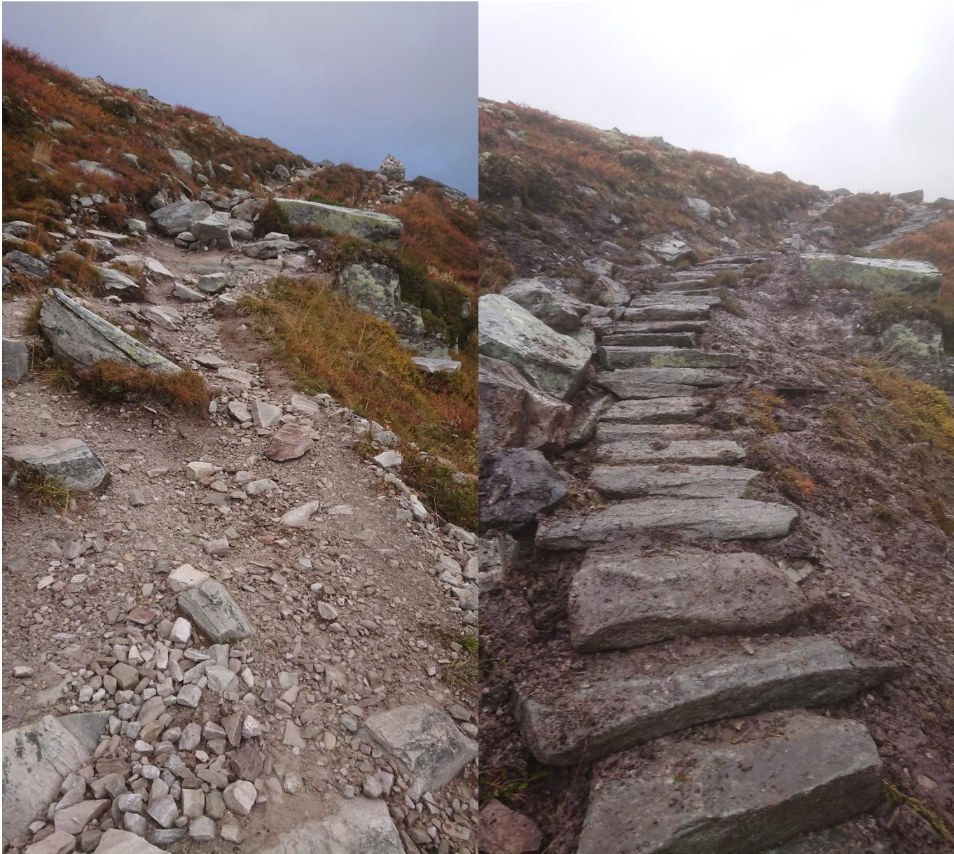
Erosjonsutsatt skråning før og etter.
