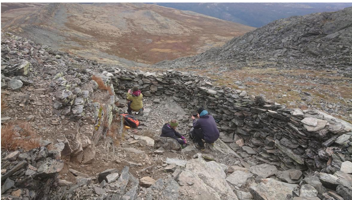
Etter at skadene på reparert.
