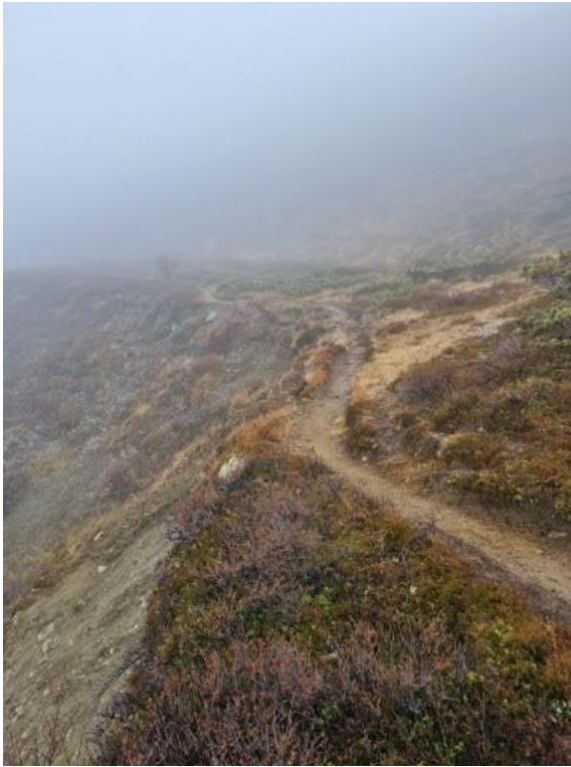
Figur 14. Bilde av DNT sti som bør flyttes bort fra den bratte delen av bekkekløfta. Foto; Finn Bjormyr, SNO.
