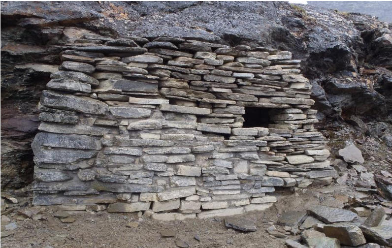
Figur 7: Hotell Hilton september 2019. Det gjenstår noe mindre arbeid før restaureringen er ferdig. Foto: Kjetil Letto, Statskog fjelltjenesten.
