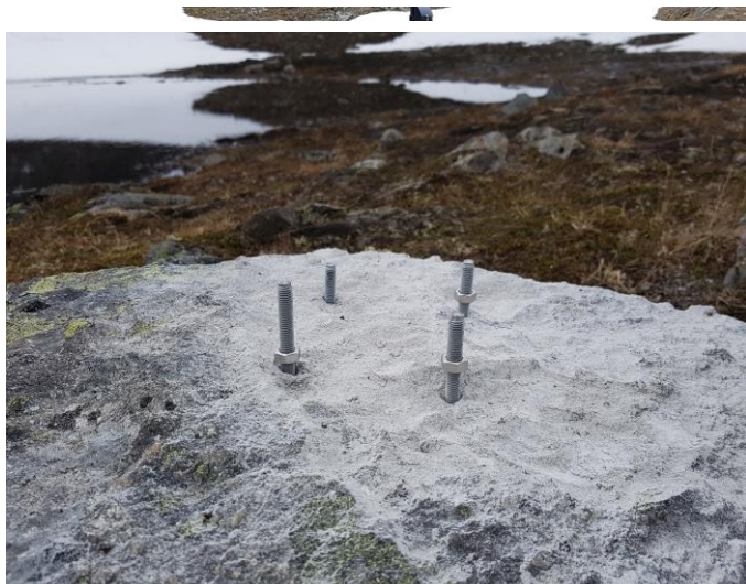
Innfesting av besøkskassa på stein. Pga skrått underlag ble det satt på justeringsmutre på undersiden av plate.
