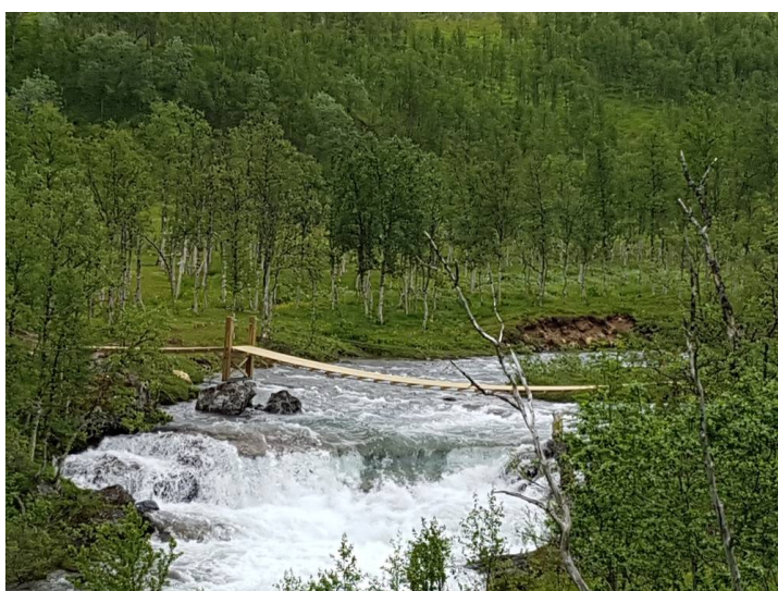
Hengebrua over Budalselva. Foto: Eivind Heimdal
