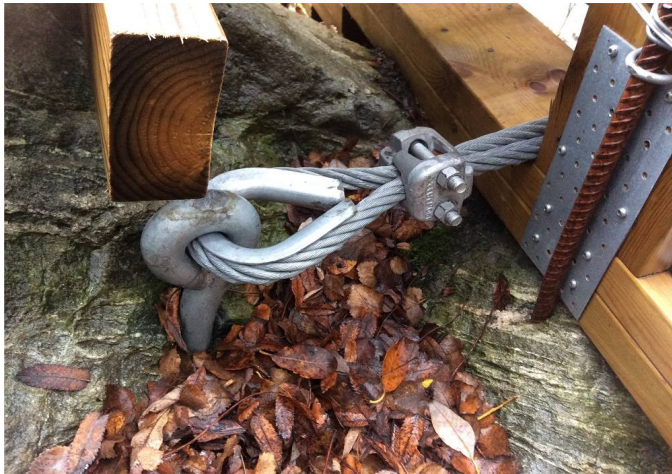
Kontroll landfeste hengebru. Foto: Fjelltjenesten
