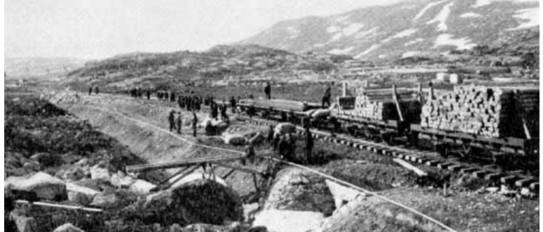
Året er 1902 og leggingen av sviller er inne i sin slutfase. Foto: Sveriges Järnvegsmuseum
