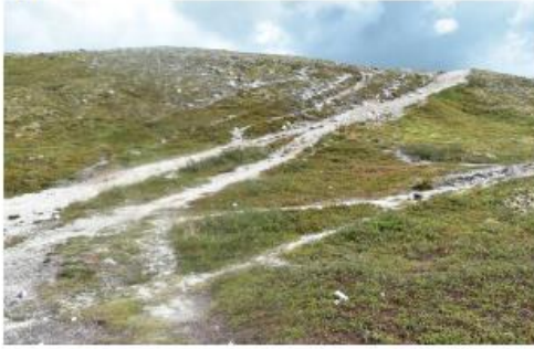
STOR - Bratt skråning med ustabil substrat
