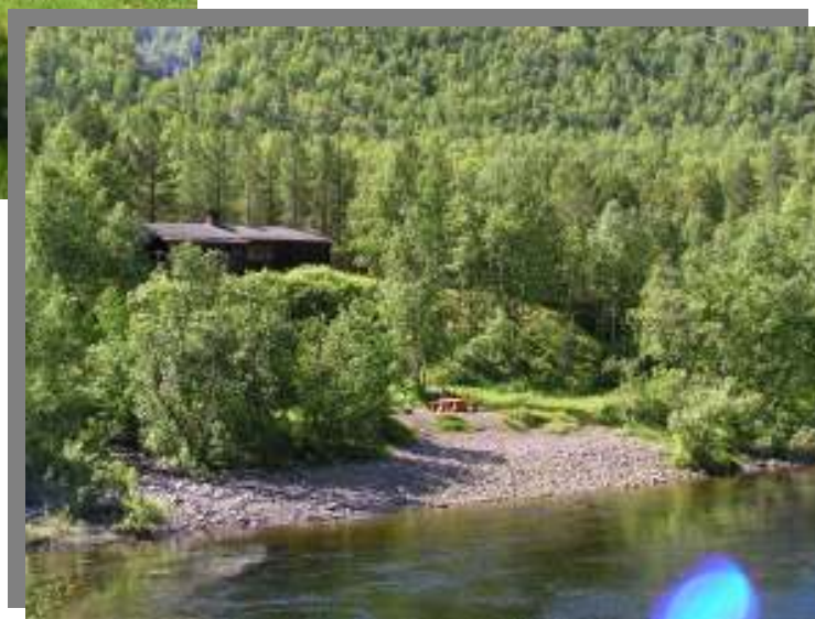
Til høyre hytta ved Nedrefoss (av mange kalt Fossestua), som eies av Troms Turlag. Ny badstue er oppført i 2008, til venstre og nedenfor hovedhytta.
