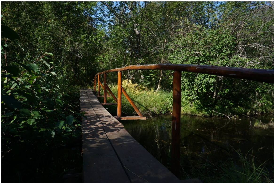
Figur 2: Bilde av bruene mellom på stien mellom Nedrefoss og Saraelv
